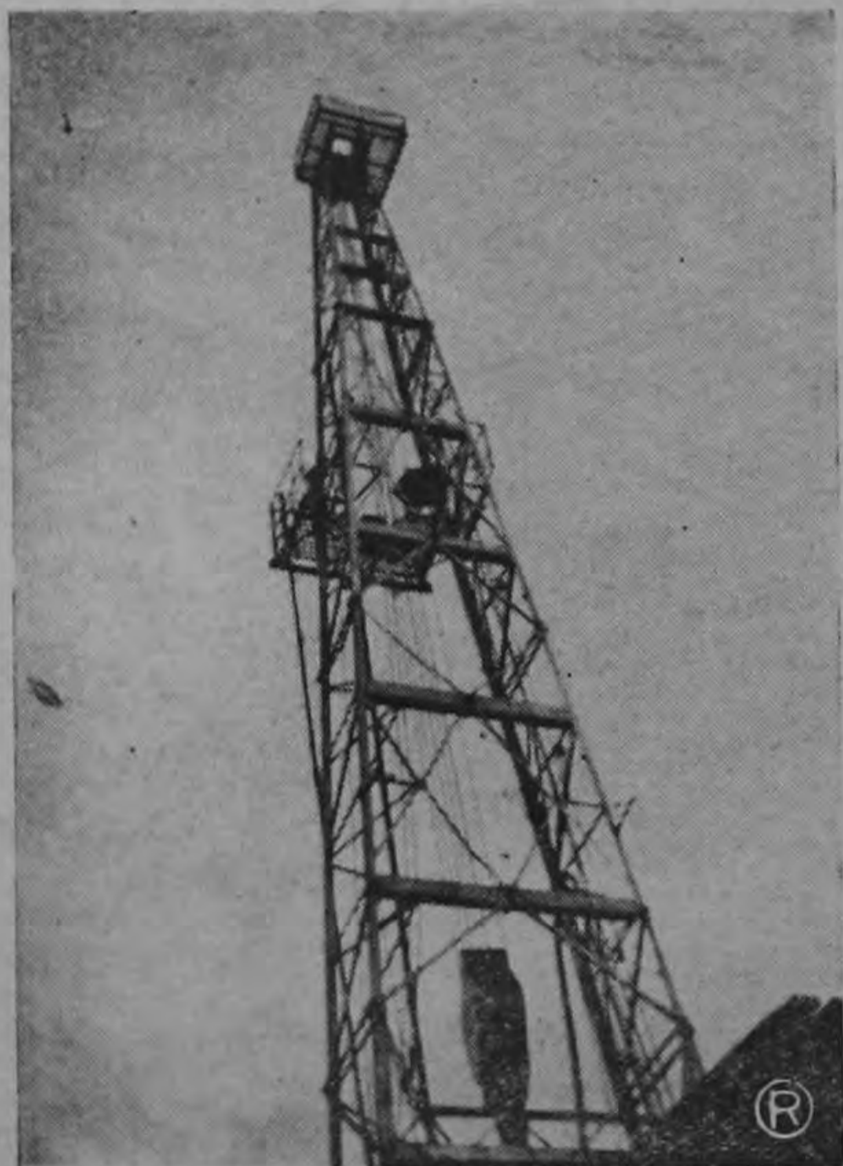
LA TORRE DEL POZO BRIS.— Perfilándose hacia el infinito, a una altura de casi 45 metros, la enorme torre del pozo petrolero de Bris sostiene la tubería que ha llegado ya a varios kilómetros de profundidad en pozos anteriores. Hacia abajo se puede apreciar la gigantesca polea voladora.
